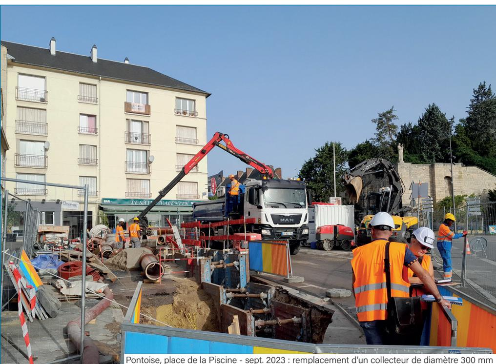
Pontoise, place de la Piscine - sept. 2023 : remplacement d'un collecteur de diamètre 300 mm
