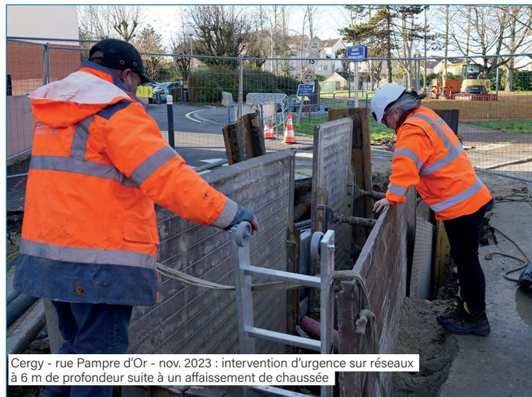
Cergy - rue Pampre d'Or - nov. 2023 : intervention d'urgence sur réseaux à 6 m de profondeur suite à un affaissement de chaussée
