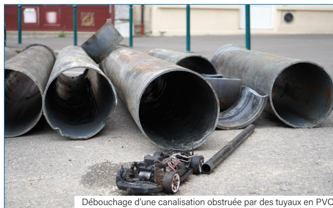
Débouchage d'une canalisation obstruée par des tuyaux en PVC
