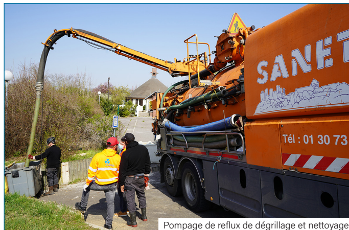
Pompage de reflux de dégrillage et nettoyage
