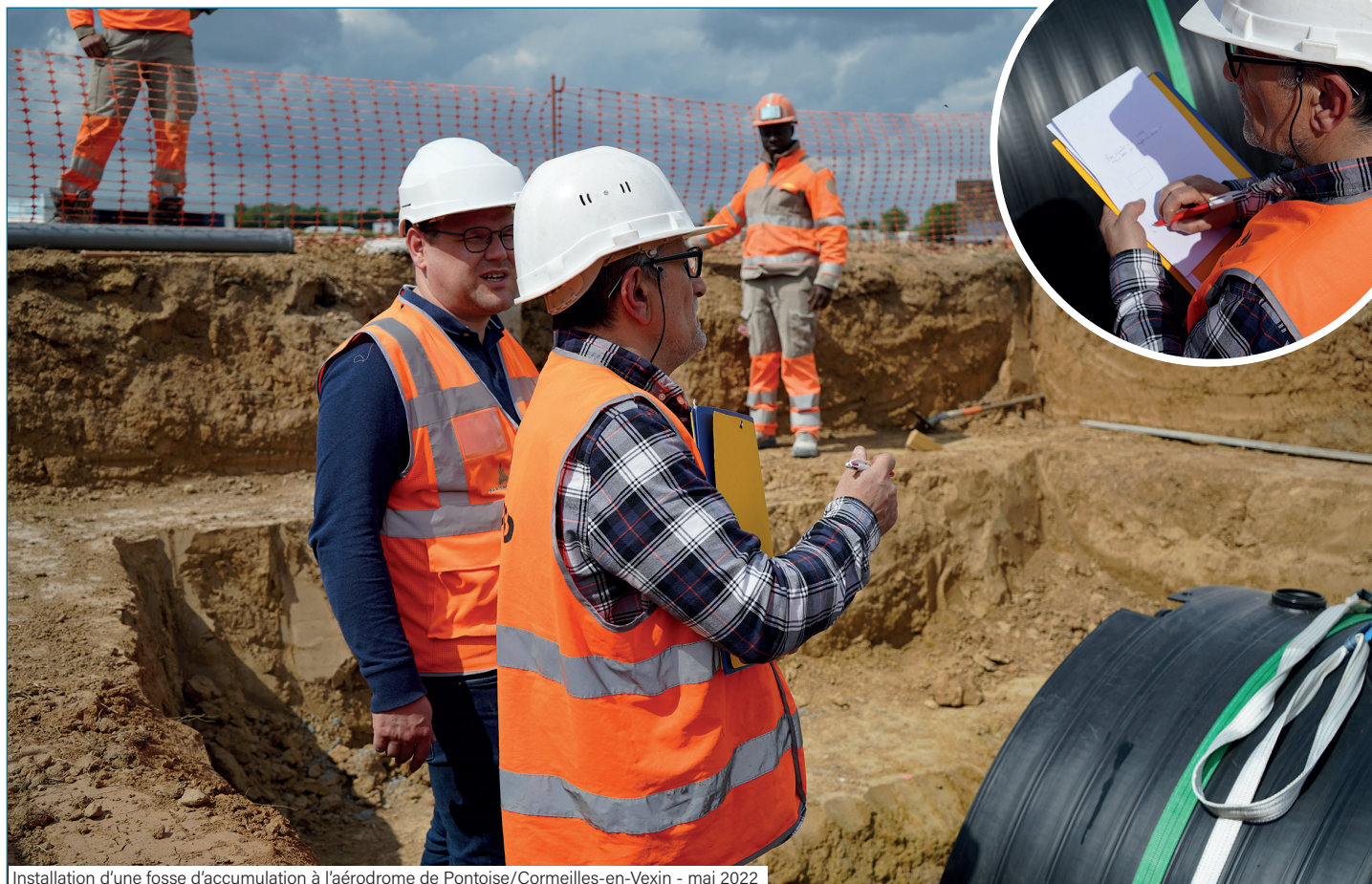
Installation d'une fosse d'accumulation à l'aérodrome de Pontoise/Cormeilles-en-Vexin - mai 2022
