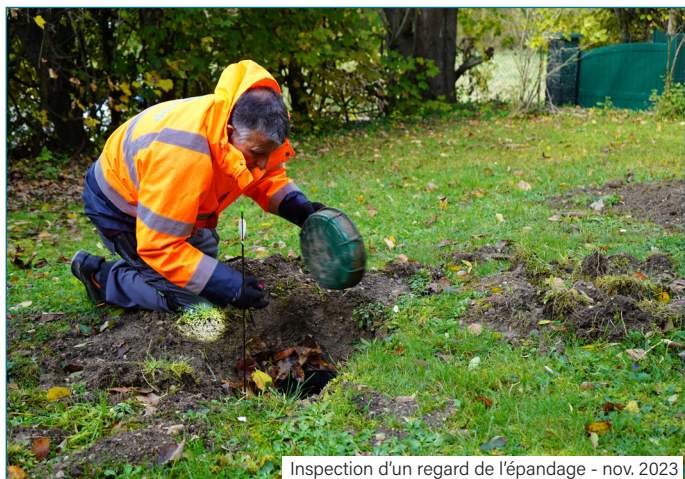
Inspection d'un regard de l'épandage - nov. 2023
