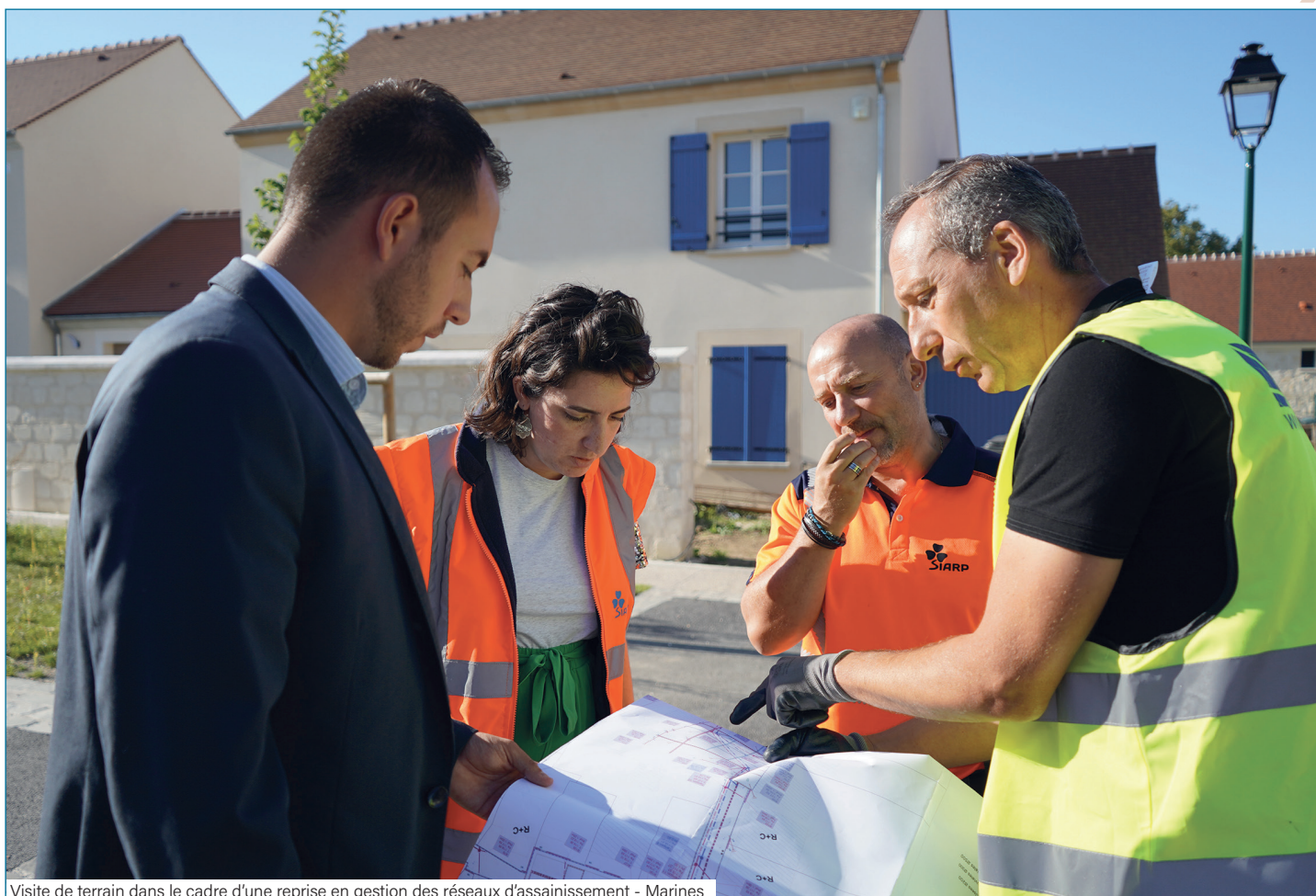
Visite de terrain dans le cadre d'une reprise en gestion des réseaux d'assainissement - Marines
